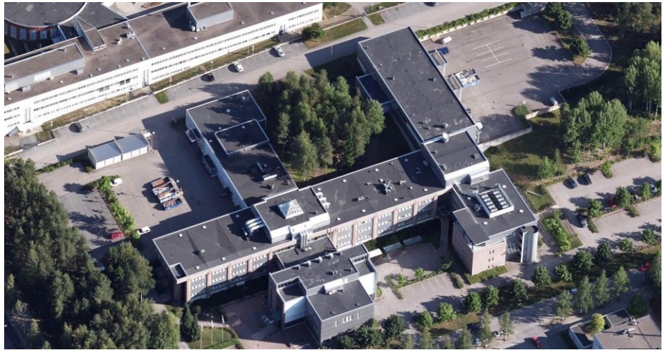
Kuva 5. Tutka-rakennus ja piha-alueetelästä päin kuvattuna. Kuvan oikeudet (copyright) Blomweb 2020.
